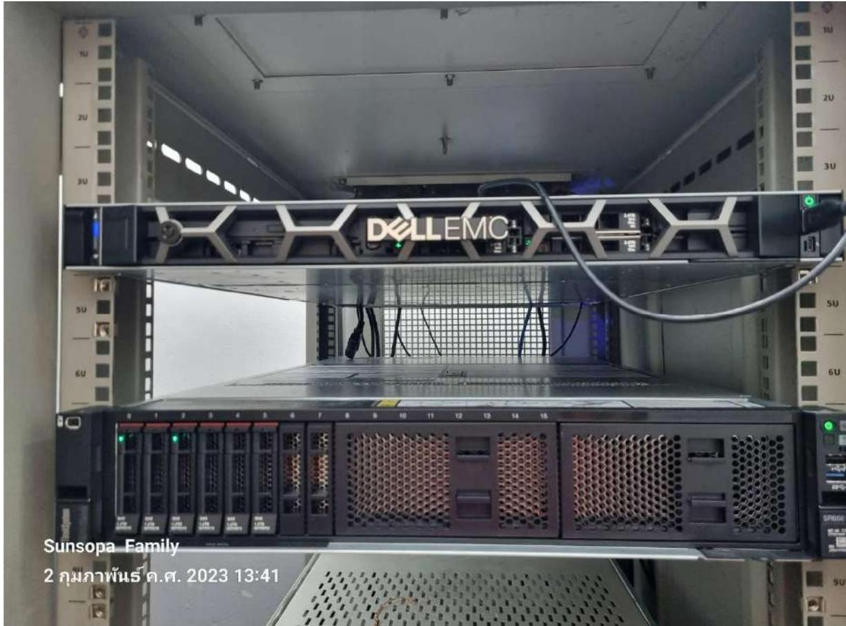
3. มี Redundant Power supply ต่อกับ UPS ขนาด 3 KVa โดยแยกจากสาย Main ไฟฟ้าแยกชุด
