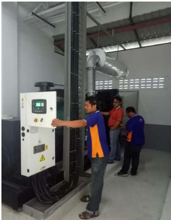
4. มีระบบสำรอง Main power สายไฟ ต่างเฟส เพื่อจ่ายให้ Server ซึ่งใช้ redundant power supply เพื่อให้ Server ทำงานได้อย่างต่อเนื่อง และใช้ ATS switch เพื่อตัดสับแหล่งจ่ายให้กับ เครื่องปรับอากาศ ในห้อง Server และ Switch hub รวมถึงอุปกรณ์ที่จำเป็นต้องใช้ไฟ อย่างต่อเนื่อง โดยจ่ายให้สำหรับ ห้อง Server ทั้ง 2 ห้อง และห้องผู้ขายฉุกเฉิน
